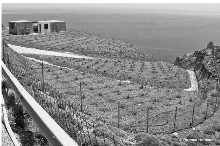
Abb. 10: Ehemalige Müllkippe geschlossen und renaturiert (Foto: H. Hermanns 2010)
