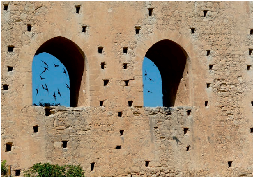
Abb. 5: Teil eines Aquäduktes, das Irakleion mit Wasser versorgen sollte. Das mittelalterlich bis antik anmutende Bauwerk wurde in der Zeit der ägyptischen Verwaltung (1832-1840) errichtet. Durch die Bögen gegen den Himmel sichtbar Mauer- und/oder Fahlsegler, die in den Nischen brüten. Foto: Lienau 2013.
