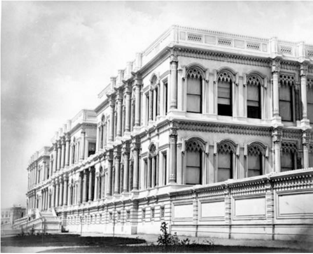
Abb. 8: Fassade des Çırağan Palastes vom Norden (Abdullah Frères? vor 1874, nach einer Aufnahme im Album Reise 1873/74 )
