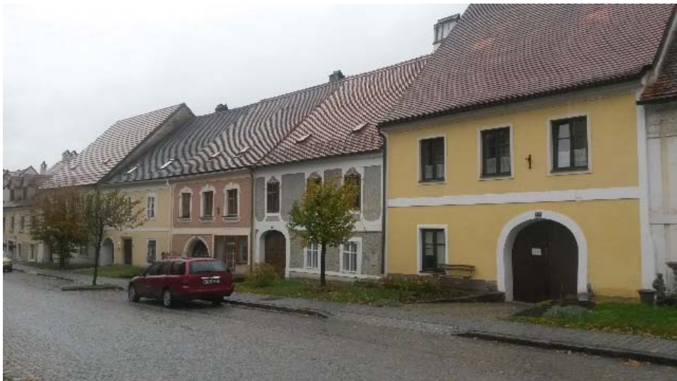
Abbildung 36 Bürgerhäuser im Ortskern von Drosendorf (Eigene Aufnahme, Oktober 2015)
