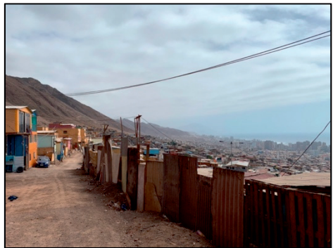
Abb. 19: Der gesamte Hang ist nun soweit geebnet, dass die Hauptachsen innerhalb des Campamento mit dem Auto befahrbar sind (Foto: BAYER, Januar 2020)
