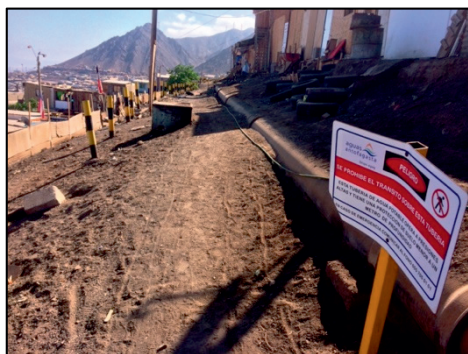
Abb. 34: Warnschild des Unternehmens Aguas Antofagasta , das auf das Begehungsverbot der unter hohem Druck stehenden Rohrleitung hinweist. Links von der Rohrleitung ist das Ende der freizuhaltenden Zone mit schwarz-gelben Pfosten markiert. Rechts von der Rohrleitung befinden sich Campamento -Wohnhäuser in der freizuhaltenden Zone (Foto: BAYER, April 2018)
