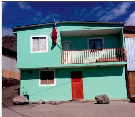
Abb. 27: Hauskonstruktionen in Antofagasta Campamentos (Foto: BAYER, Dezember 2018)
