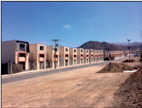
Abb. 25: Viviendas Definitivas im Konstruktionsprozess (Foto: BAYER, November 2018)
