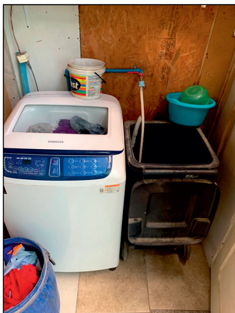
Abb. 44: Haushalt im Barrio Transitorio : Das von der Waschmaschine genutzte Wasser wird in der schwarzen Tonne gesammelt und dort mit kleineren Eimern und Schöpfbechern für andere Nutzungen entnommen (Foto: BAYER, Dezember 2019)
