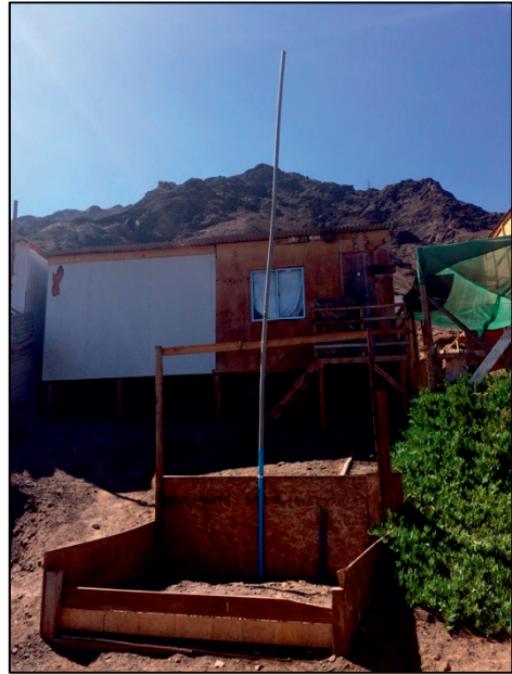
Abb. 37: Geschlossener Pozo Séptico mit Geruchsabzugsrohr (Foto: BAYER, April 2018)
